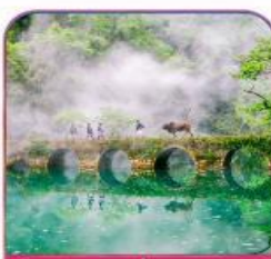
สะพานสิ่วซัง
